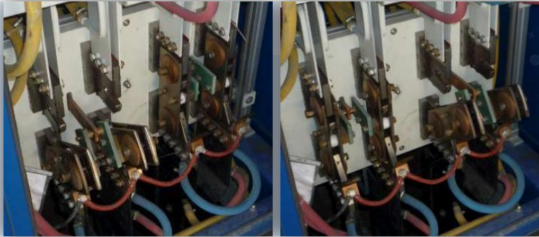
Switch de transferencia neumático; selección horno1 – selección horno2.
